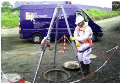
Generalinspektion einer Abscheideranlage (Dichtheitsprüfung)
